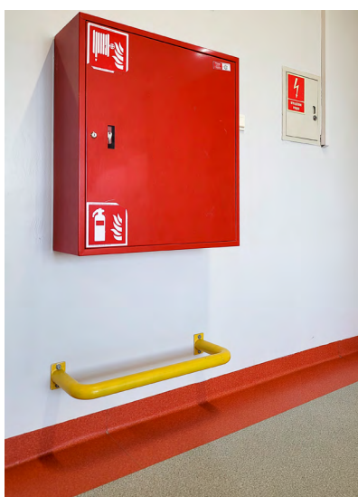
Ilustracja 56. Przykłady zabezpieczenia elementów wystających przed lico ściany na odległość większą niż 0,1 m. Na zdjęciu po lewej przykład zastosowania poprzeczki, pośrodku przykład obudowy gabloty, po prawej zabezpieczenie gabloty z zastosowaniem ciężkich donic, fot. Katarzyna Guratowska
