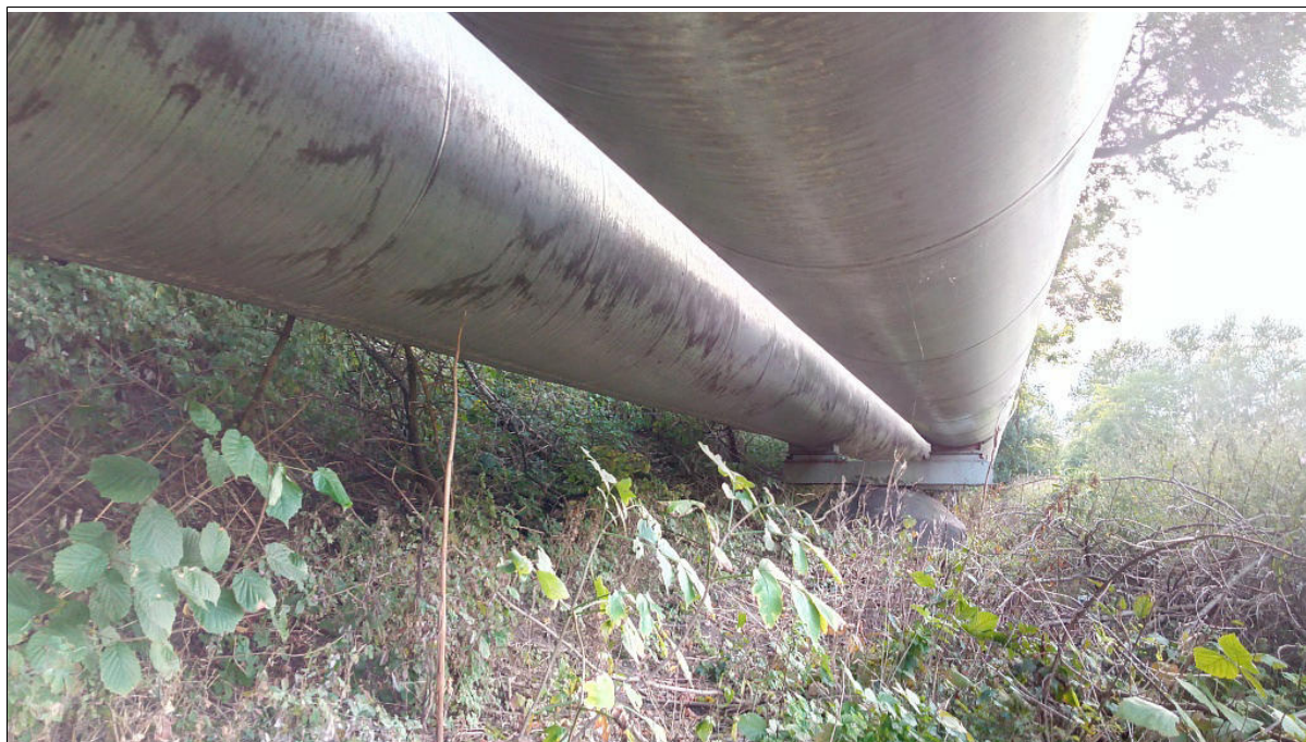
Czoło osuwiska schodzące na stopę podtrzymującą rurociąg
