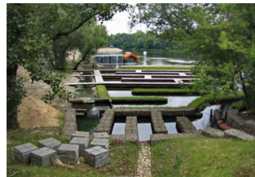
Biofiltr - konstrukcja inżynierska, pomagająca oczyszczać wodę dopływającą do zbiorników przy pomocy roślin i mikroorganizmów
